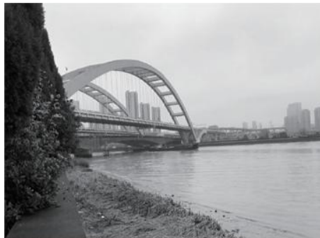
桥梁、物隧道变形监测
